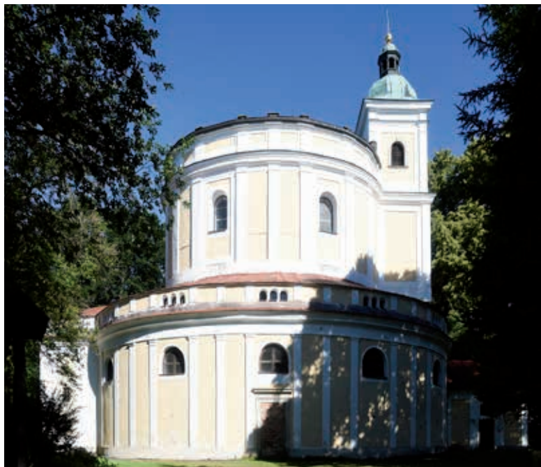
Wallfahrtskirche St. Anna, Tannaberg Poutní kostel sv. Anny, Tanaberk
